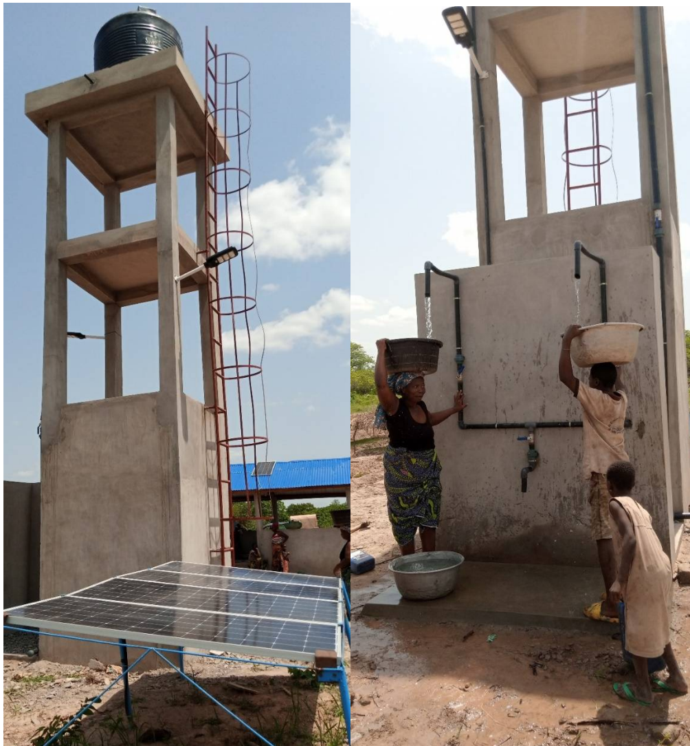
Planche 6 : Forage équipé à Dassa au profit des bénéficiaires
