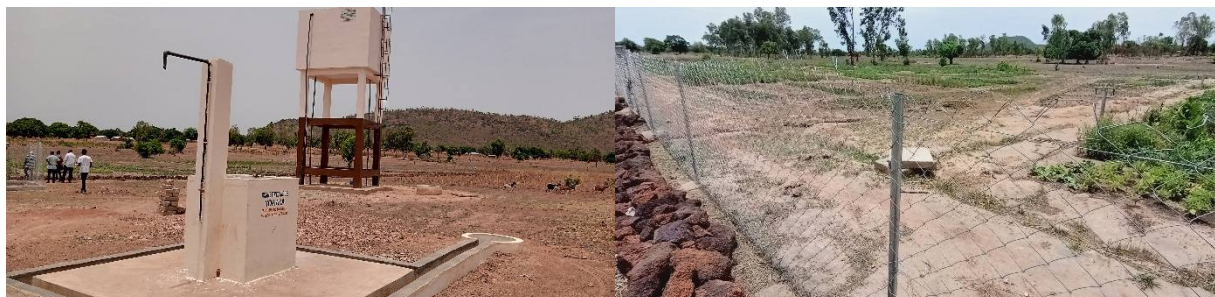
Planche 2 ouvrages du Site de Yopiaka
