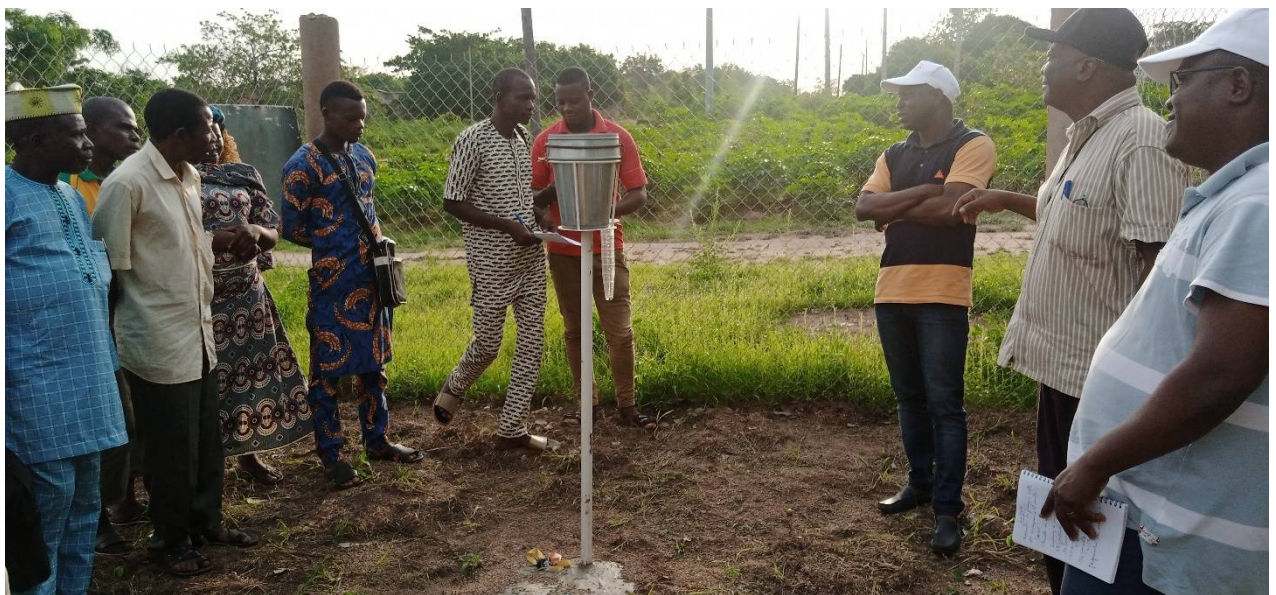
Photo 8 Pluviomètre installé dans la cour des locaux de l'arrondissement de Kaboua à Savè
